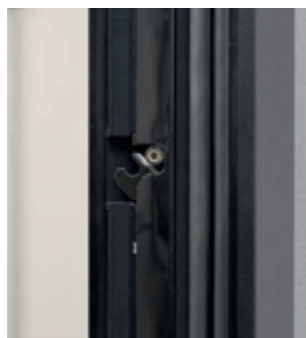
Der Verschluss mit pferdekopfförmiger Verriegelung im Rahmen
